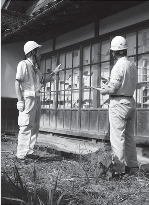
南砺市SCの「空き家・空き地等管理サービス事業」では、現在10人ほどの会員が活躍している。センターが作成した管理チェックシートに沿って、建物の破損や雑草の繁茂状況などを目視で確認する
